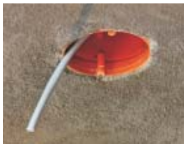
KBT... doboz a KBP... csillár-kapocs szereléséhez előkészített kivezetett kábelrel
