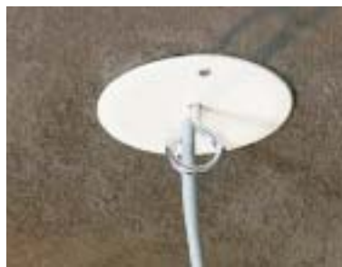
V 68 S fedéllel ellátott KBT... doboz kivezetett kábelrel és KBP... csillár-kapocccsal
