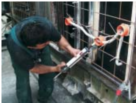
Az átvezetések tömítése (bitumenes gitt).
