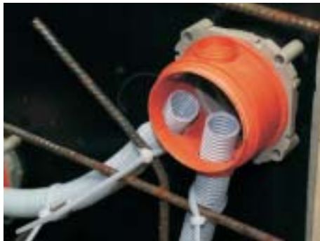
A KBT palástjába szerelt hajlékony csövek.
