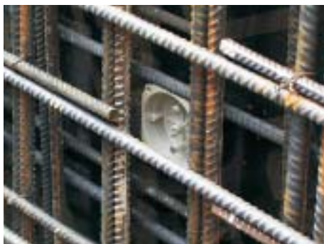
A zsaluzatra erősített KBV fedél.
