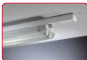
Szerelés NAL csatornarendszerre NAL 1025 felfüggeszthető konzollal
