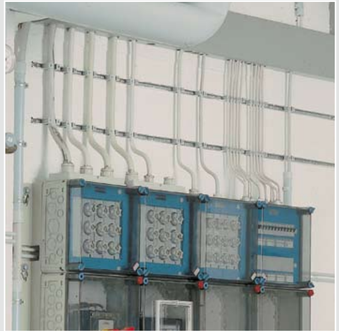
Rendezőcsatornával ellátott kábelbevezetés fedele.
