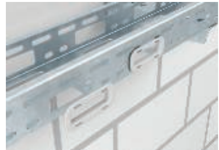
A KSR DR 910 típusú kábelvédő gyűrűk behelyezése az AZ-szerelőcsatorna pofalemezébe.
