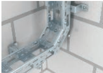
Függőleges sarokidom szerelése SV típusú csuklós összekötőkkel.
