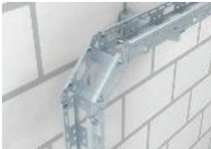
Függőleges sarokidom szerelése SV típusú csuklós összekötőkkel.
