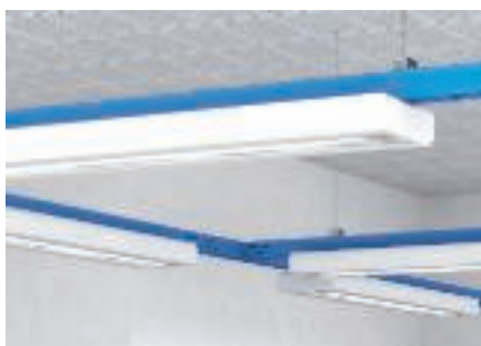
A fénycsőtartó-tálca felfüggesztése MAH központos függesztett tartóval és menetes rúddal
