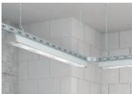
A fénycsőtartó-sín felfüggesztése láncsal és függesztőkengyellel
