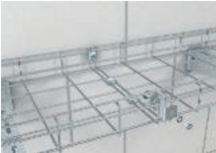
C-profilú rácsos kábeltálcák hosszanti toldó kötése GSV 34 típusú csavaros toldásponti összekötőkkel.
