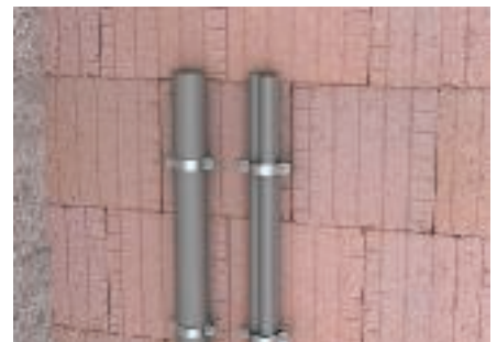
Függőleges nyomvonal szerelése oldalfalon
