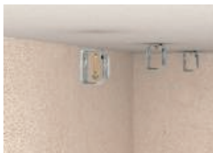
A csoportos kábelrögztítők egyidejű szerelése horgonycsavarokkal átmenő szerelésként
