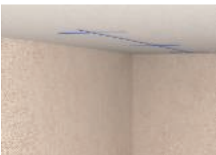
A furatok helyének pontos megjelölése csapózsínrel.
