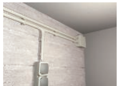
T-leágazás szerelése
